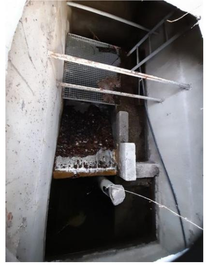
*Photos du dégrilleur partiteur, du décanteur-dessableur et du dégrilleur fine maille au niveau de la prise d'eau en rivière*
