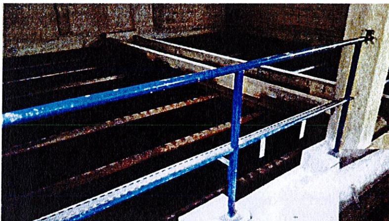
→ vue du bassin de décantation type "pulsator" H.S ( sert de simple décanteur statique)
